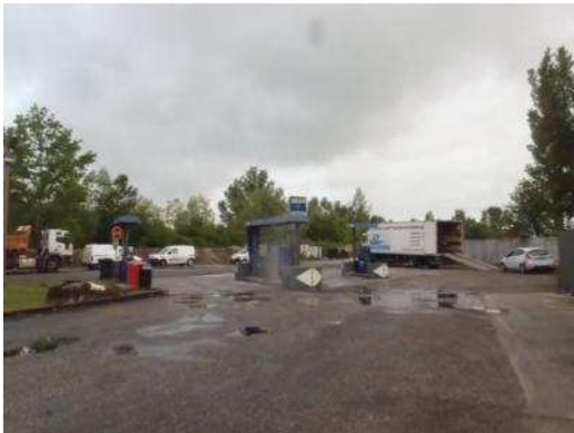
Photographie 1 : Vue d'ensemble de la station-service
