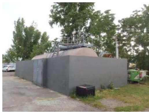
Photographie 2 : Vue sur le réservoir aérien et une partie de l'aire de dépotage
